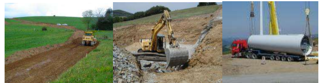
Photographie 35 : Illustration d'un chantier éolien
